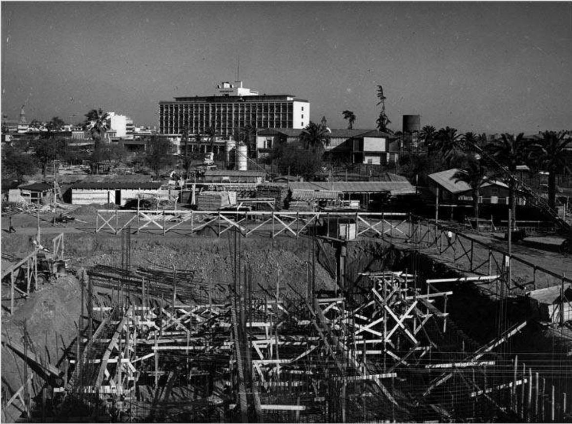
Cimientos de la Torre 13 de la Remodelación San Borja, al fondo la Posta. Fotografía vía Santiago Nostálgico.
